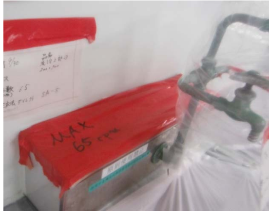
(木の蓋は、粘着テープで汚染部を固定)
