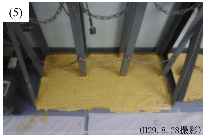
【汚染固定前】 → 【ストリップابلペイントによる汚染固定後】
