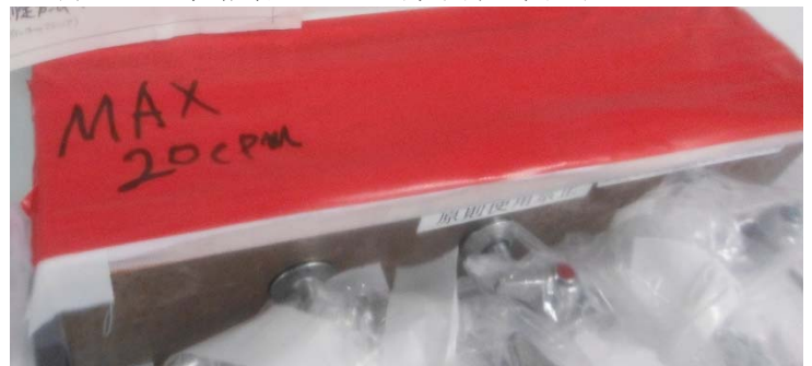
(蛇口は粘着テープで汚染部を固定し、ビニル袋養生)
