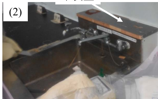
(表面状態に起因し、上面の木製蓋及び蛇口の除染は困難)
